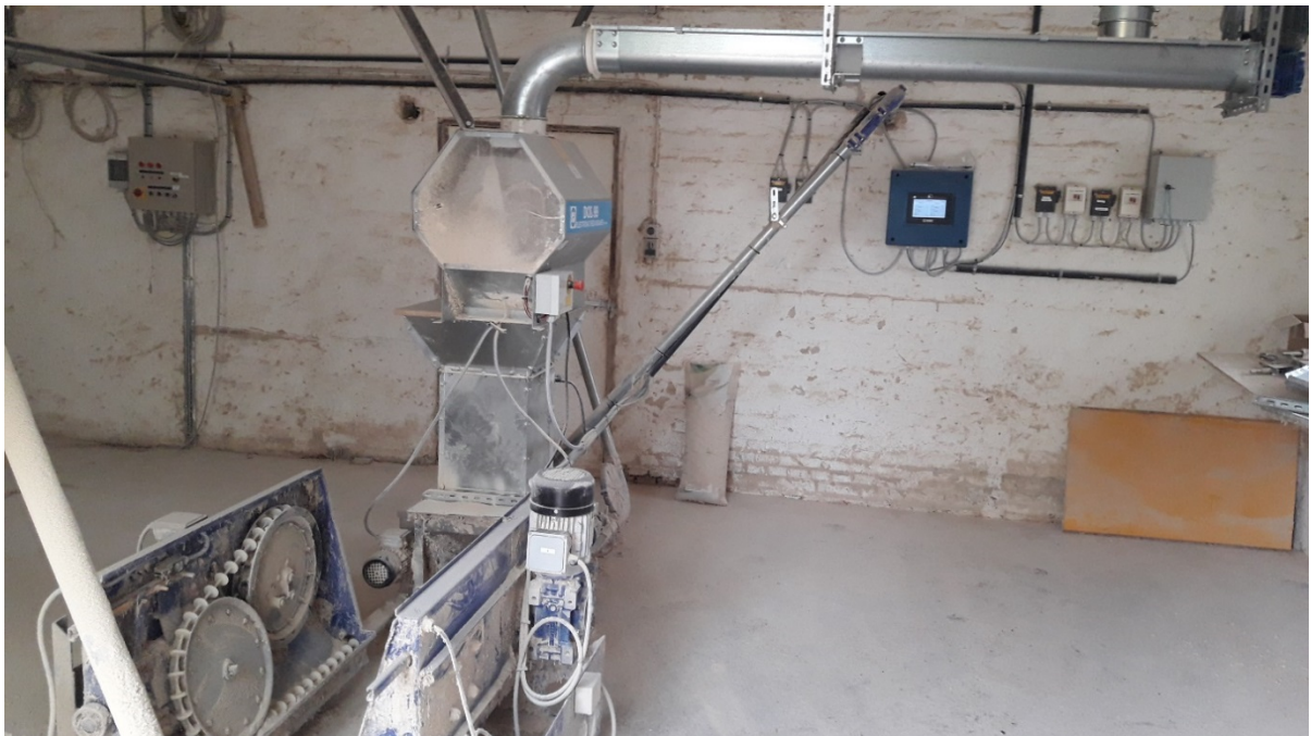
Billede 3. 2-strengsfoderanlæg med portionsvægt. Foderet kommer ind via snegle-rende fra færdigvaresilo placeret udenfor. Derfra afmåles en portion foder i vægten, og dette tildeles enten streng A eller B afhængigt af, hvilken trækstation, der er sat til at køre. Der kan kun køre én trækstation ad gangen.
